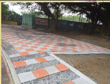
操場西側地坪改善工程施工現況照片(109 年 2 月底完工)
