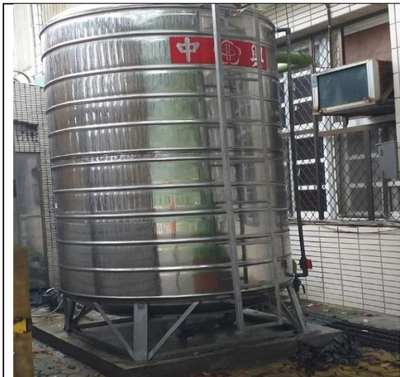
在校園環境方面:水循環之調節運用，建構雨水收集系統，引進溝渠水灌溉花圃，讓校園環境更因水而更加流暢、優雅和美麗；在空間運用方面：藉由既有斜屋頂天溝收集雨水，運用高低差關係，地面上設置具有可觀測性雨水收集水塔，配合教學展示板，營造水資源教育場域；在設施關係方面：利用雨水收集系統與自來水系統適當調整分配，解決校舍停水後造成用水不便問題，設置溝渠水引進灌溉花圃，有效運用天然水源，增添環境教育的教學空間。
